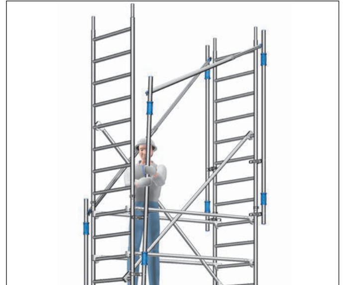
Bild 5: Versetzen des MSG nach oben
